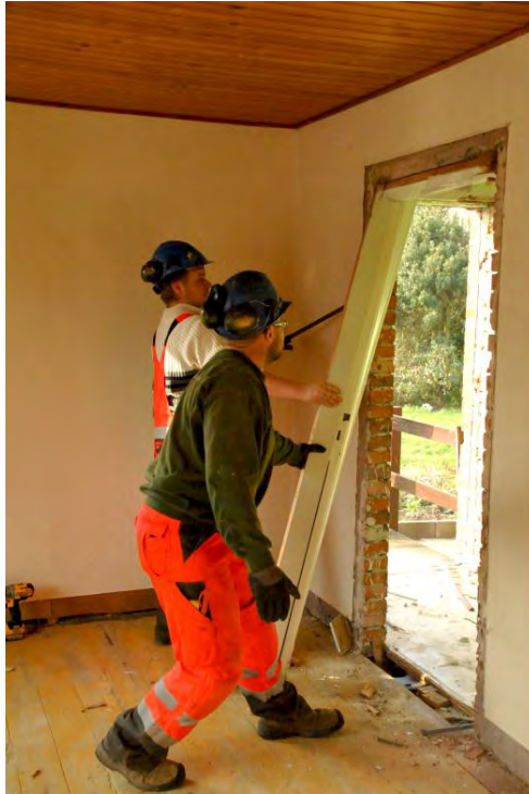
Foto 2: Det er vigtigt at have fokus på nedrivningsmetoden for at kunne genbruge materialerne (Kilde: Energibyen Skive)
